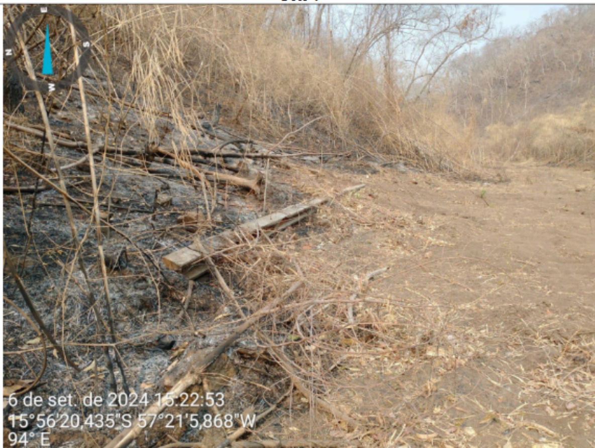
Poste encontrado ao lado do poste onde o incidente foi relatado
