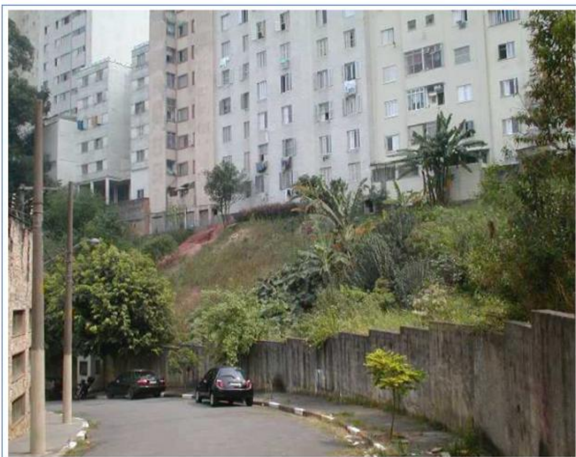
FOTO 01 – Situação do terreno – topografia original – encosta de morro.
