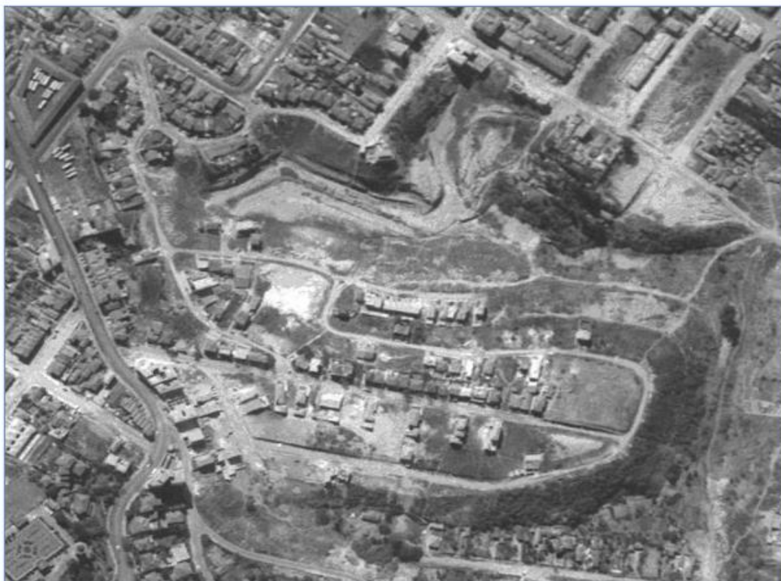
Figura 2 – Imagem aérea de 1958 (Fonte: Geoportal6 ).
